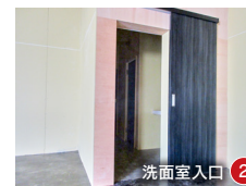
洗面室入口 ②
